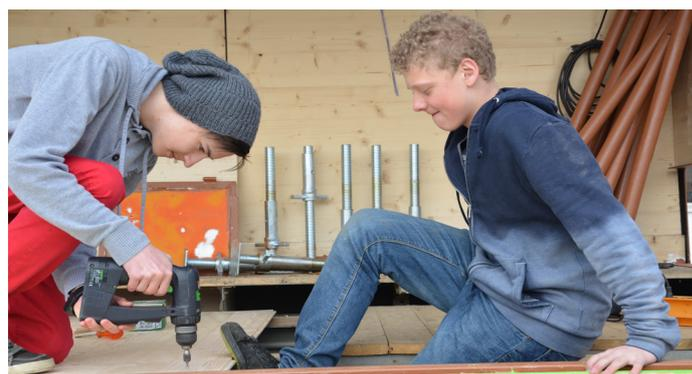
Gleichzeitig wird der neue Boden fertiggestellt. Zum Teil müssen sich die Schüler dafür ziemlich verrenken, damit der Boden am Schluss auch genügend stabil eingebaut ist. Einige Bodenlatten müssen zuerst noch mittels Fräse und Hobel angepasst werden.
