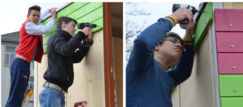
An der Front- und der Heckseite ist die Schalung schnell angebracht. Doch auf der Seitenfront bereitet dies schon mehr Mühe. Um die langen Schalungslatten in dieser Höhe anzubringen, werden viele Hände gebraucht und die Jungs müssen sich gegenseitig helfen.
